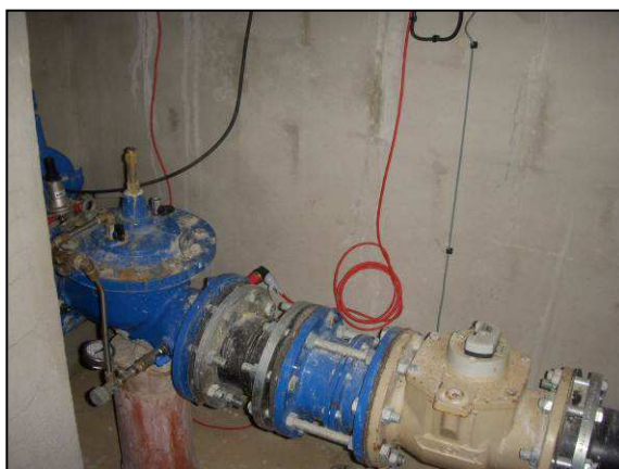
Contador de contraste de 150 mm y válvula reguladora
