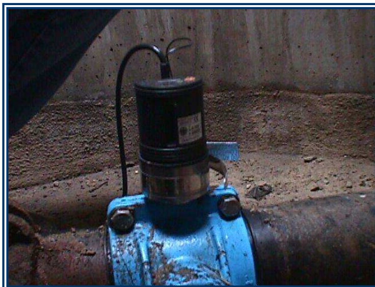
Aspecto de unidad de registro "Permalog" instalada sobre accesorio de la red.
