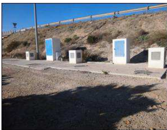
Arqueta de la Toma de la Epa al anillo de Torre Pacheco y contador
