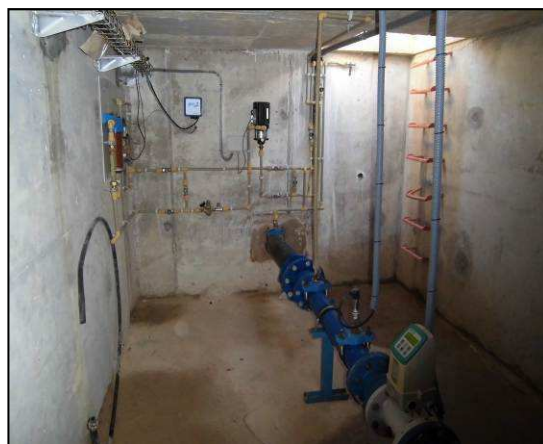
Arqueta de la Toma de la Epa al anillo de Torre Pacheco y contador
